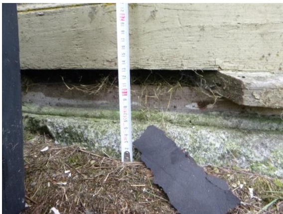
Kuva 29. Maanpinta on paikoitellen noussut korkealle rakennuksen seinustoilla. Kuvassa kivijalkaa näkyvillä n. 6 cm.
