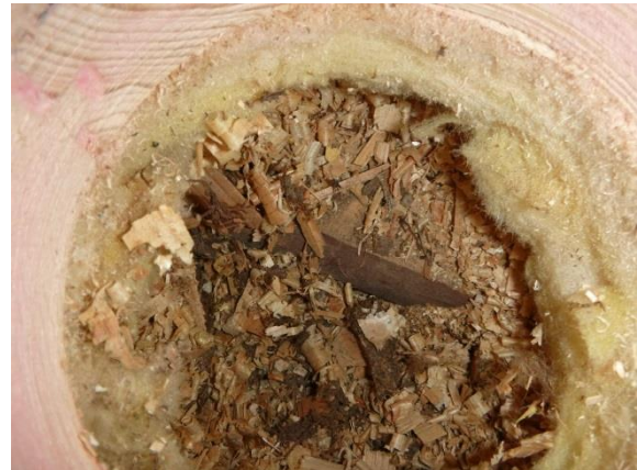
Kuva 18. Alapohjan lämmöneristeenä on turvetta, sahanpuurua ja mineraalivillaa.
