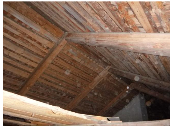
Kuva 83. Vanha päre on jätetty aluskatteeksi.
