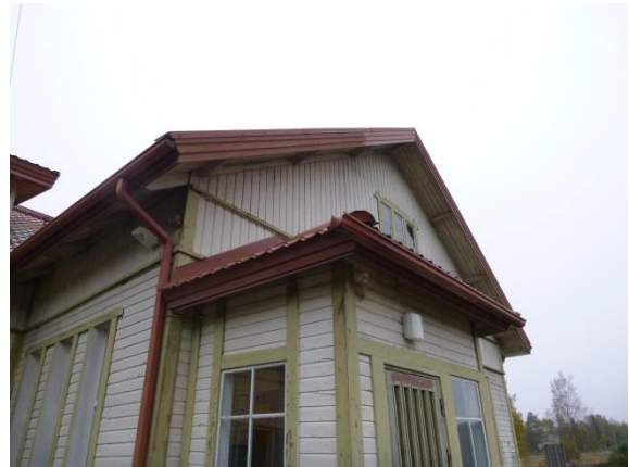
Kuva 26. Verannan katolta sadevesi poistuu vapaasti tip-pumalla.
