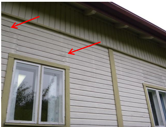
Kuva 33. Lounaissivun ikkunakokoa on muutettu madaltamalla kahden ikkunan osalta todennäköisesti vuonna 1959 tehdyn laajennuksen yhteydessä. Ilmanvaihtoventtiili on suljettu.
