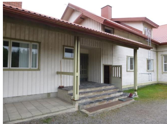
Kuva 24. Vanhan ja uuden rakennusosan liitoskohta pihan puolelta idästä.
