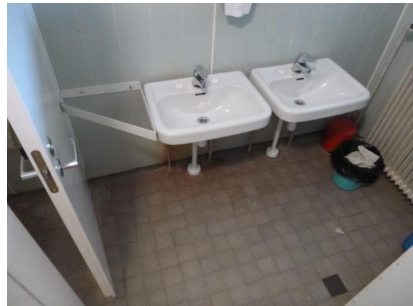
Kuva 69. Yleiskuva, poikien wc-tila.
