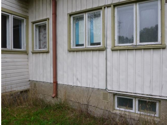
Kuva 37. Laajennusosan julkisivu on verhoiltu lounaissivulta pesutilojen kohdalla kovalevyllä ja pystyrimoin.
