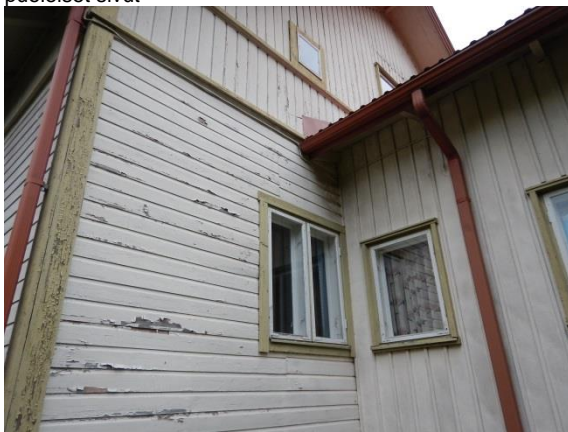
Kuva 23. Vanhan ja uuden rakennusosan liitoskohta eteläkoillissivulla.
