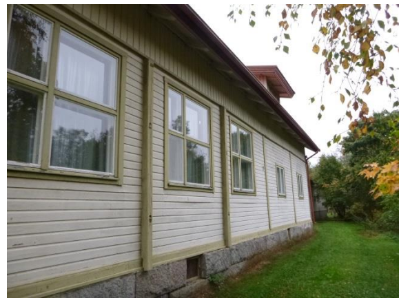
Kuva 22. Julkisivu lounaissuunnalta kuvattuna.
