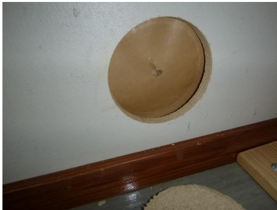
Kuva 48. Rakenneavaus 1, liikuntasali, ulkoseinä
