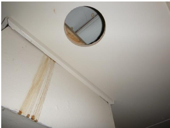
Kuva 71. Rakenneavaus 4, suuri luokkahuone sisäkatto.
