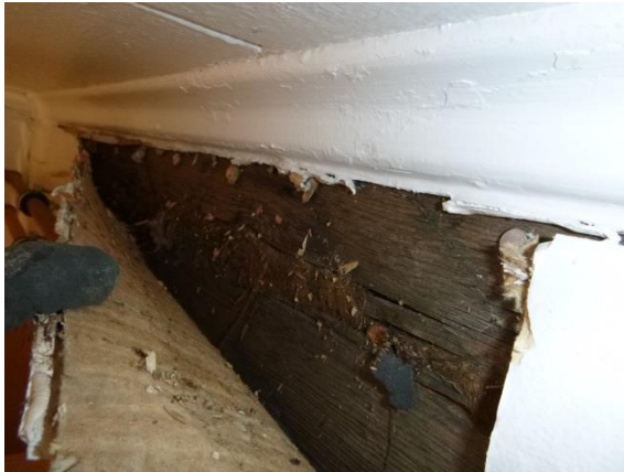
Kuva 80. Rakenneavaus 8, keittiön eteinen, sisäseinä.
