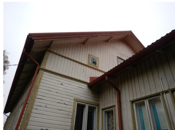
Kuva 34. Etelä-koillispäädyssä olevat suuremmat ikkunaukot on pienennetty todennäköisesti 1959 tehdyn laajennuksen yhteydessä.
