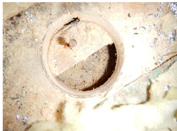
Kuva 20. Rakenneavaus 5, AP2, vanha keittiö
