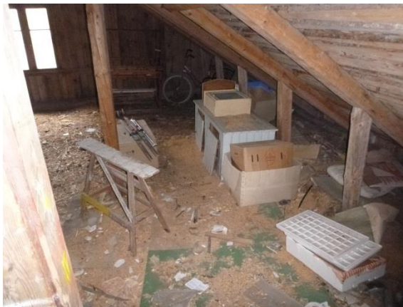
Kuva 82. Yleiskuva vanhan osan ullakosta.
