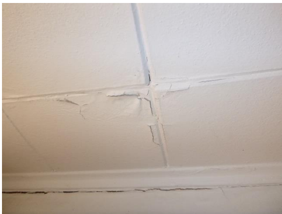
Kuva 75. Rakenneavaus 6, keittiön eteinen, sisäkatto.
