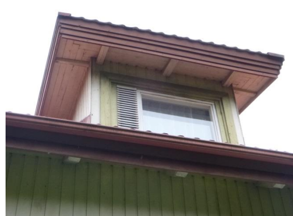
Kuva 36. Kattolyhty lounaispuolella. Toinen kattolyhty on rakennettu myös koillispuolelle rakennusta.
