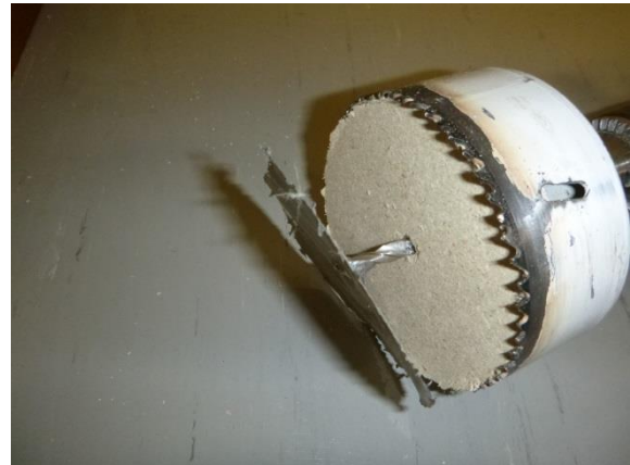
Kuva 51. Rakenneavaus 2, suuri luokkahuone, ulkoseinä
