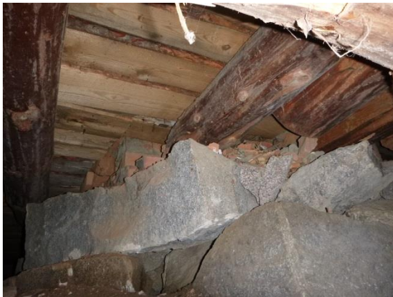
Kuva 4. Tulisijan perustusten kohdalla on tiilenkappaleita.
