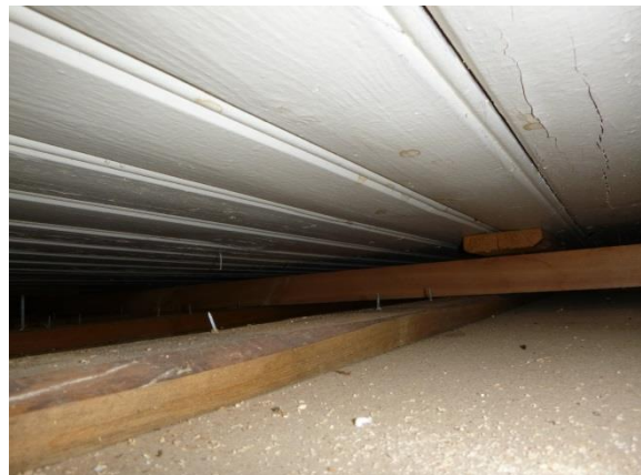
Kuva 72. Rakenneavaus 4, suuri luokkahuone sisäkatto.
