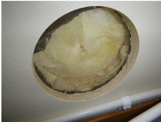
Kuva 50. Rakenneavaus 2, suuri luokkahuone, ulkoseinä
