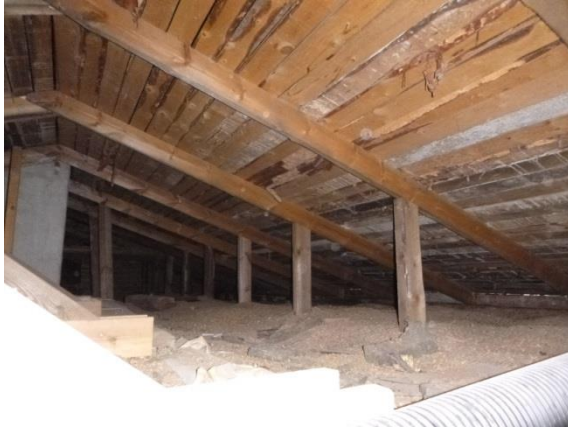
Kuva 84. Yläpohjatila toisen kerroksen asuinhuoneiden yläpuolella.
