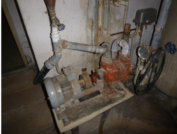
Kuva 92. Kierto-vesipumppu.
