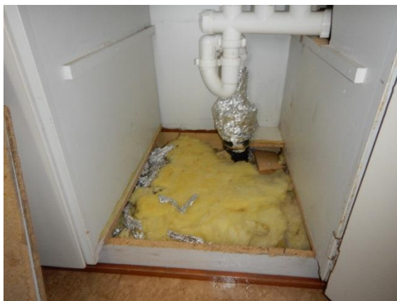
Kuva 19. Keittiökaapin sisäpuolelle on asennettu mineraalivilla.
