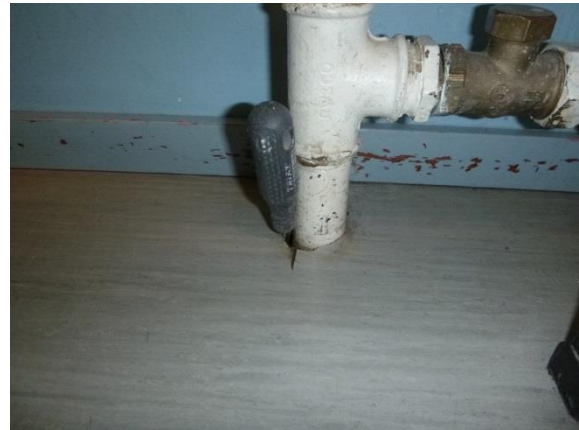
Kuva 67. Tiivistämättömiä läpivientejä.
