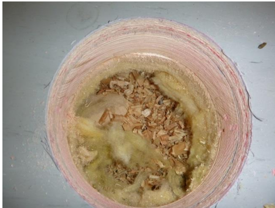
Kuva 17. Rakenneavaus 3, AP1, suuri luokkahuone
