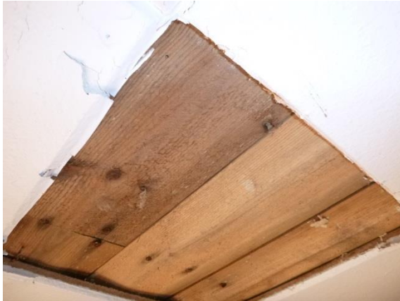
Kuva 77. Kattopaneloinnin yläpuolinen laudoitus.
