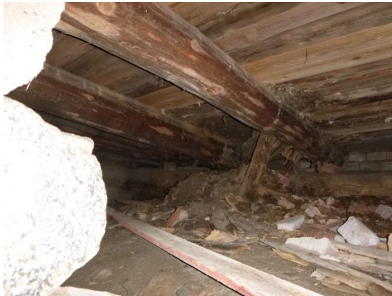
Kuva 14. Lahovaurio suuren luokkahuoneen purettujen tulisijojen perustusten edustalla
